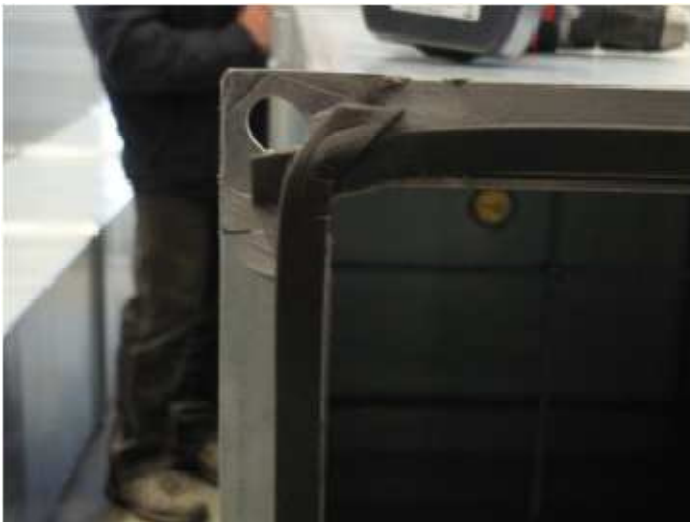
Abb.1 – “Über-Kreuz-Verlegung“ von Dichtungsband bei Dichtheitsklasse C
